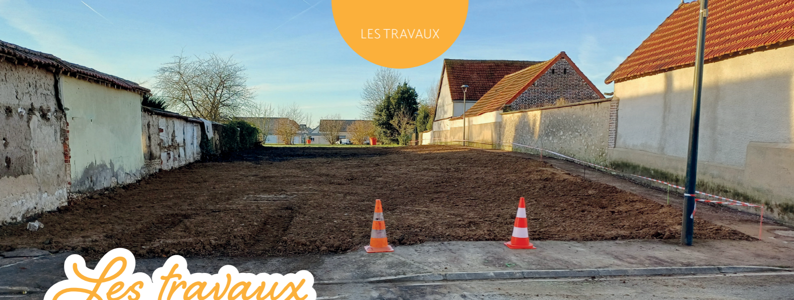
Terrain de la « maison d'Émilienne » après la démolition
